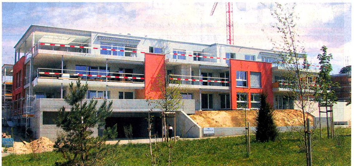
Der Bau der vier Mehrfamilienhäuser «Ribi-Seeblick» ist in der Endphase: Bereits in wenigen Tagen können die ersten Eigentumswohnungen bezogen werden.
