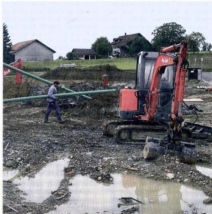
Im Gebiet Weieräcker werden 30 Häuser gebaut. Bild: Andreas Wolfensberger
