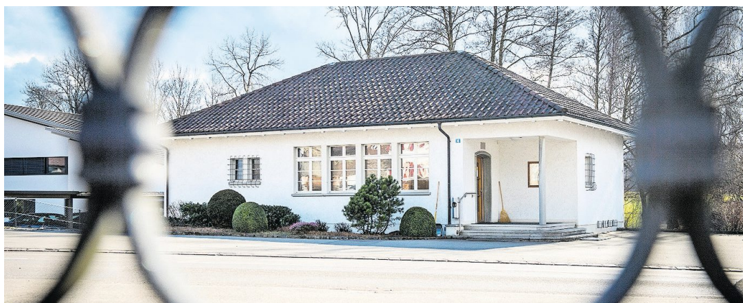
Das evangelische Kirchgemeindehaus in Alterswilen wird saniert.
