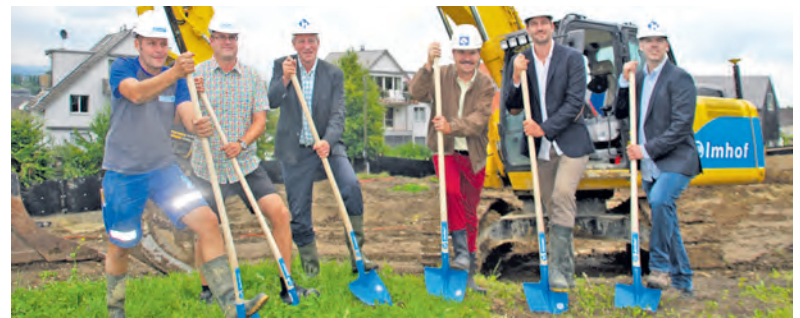
Roger Strebel, Frank Lötscher, Konrad Häberlin, Frank Schiltknecht, Yves Häberlin und Jens Gatellier (von links nach rechts) beim Spatenstich. Bild: vf
