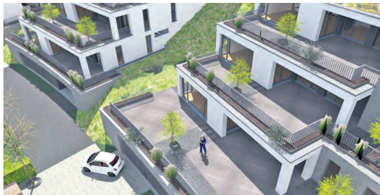
Die Terrassenwohnungen des Besmer-Panoramaprojektes.
